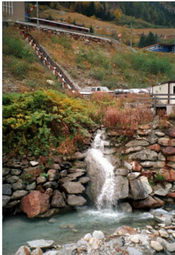
Abbildung 7.10: Treppenartige Kühlrinne beim Ausfluss des Baustellenabwassers der Neat (Foto: 12.10.02).
