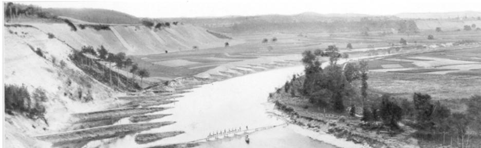
Fig. 4-10: Thurkorrektur von 1882 unterhalb von Andelfingen, bei der Rutschhänge mit Bühnen gesichert werden (aus: Salathé, 1997).
