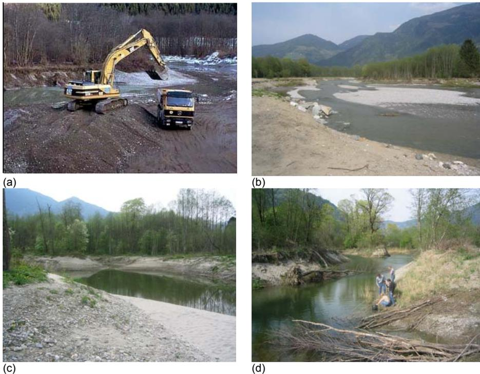
Fig. 4-16: LIFE-Projekt „Auenverbund Obere Drau“ ( $MQ = 74,7 \text{ m}^3 \text{ s}^{-1}$ ): (a) während der Bauarbeiten und (c) neu entstandene Flutmulde (Sommer 2003); Obere Drau bei Kleblach-Lind (b) Aufweitung und „neuer Altarm“ kurz nach Beendigung der Bauphase im Sommer 2003 (Fotos: C. Bratrich und Projekthomepage: <http://panda.wwf.at>).
