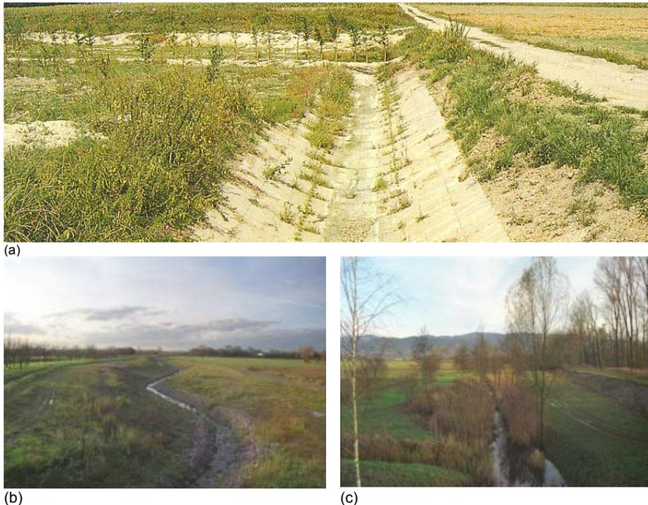
Fig. 4-7: Sulzbächle bei Bühl ( $Q_{\text{bordvoll}} = 7 \text{ m}^3 \text{ s}^{-1}$ ): (a) Ursprünglicher Sohlchalenausbau wie er noch oberhalb der revitalisierten Strecke besteht, (b) in der Bauphase, (c) Zustand 2002 knapp zehn Jahre später (Fotos: Scherele LfU, A. Schmunk).
