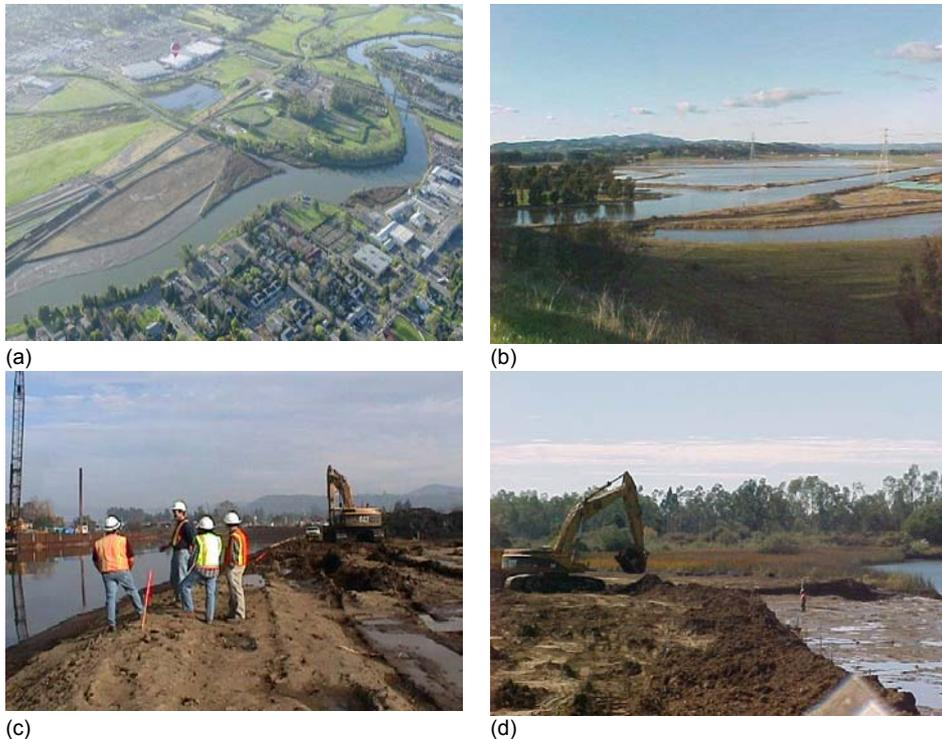
Fig. 4-22: (a) Napa River bei Napa Stadt mit aufgewerteter Strecke am rechten Ufer, (b) gezeitenbeeinflusste Marschlandschaft im Unterlauf, (c, d): Bauarbeiten bei der Aufweitung des Gewässers um den Hochwasserschutz bis zu  $HQ_{100} = 40'000 \text{ Cubic Ft. s}^{-1}$ , bzw. rund  $11'000 \text{ m}^3 \text{ s}^{-1}$  zu sichern (Fotos: Napa River Flood Protection Project).
